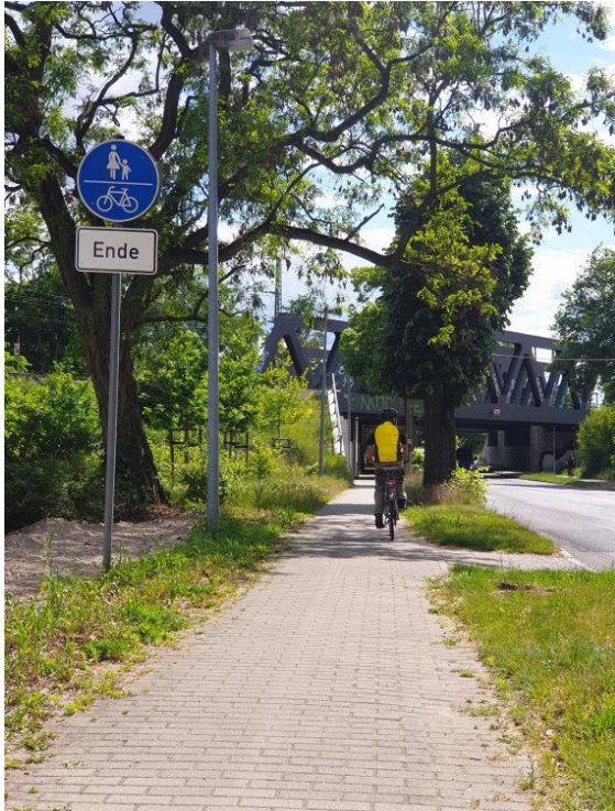
Abbildung3: Zweirichtungradwege enden häufig abrupt an Ortseinfahrten, ohne dass es eine Verkehrsführung, insbesondere für den Spurwechsel des linken Radverkehrs, gibt. Eine Folge ist wie hier, dass Radfahrende auf den Gehwegen weiterfahren und sich und andere Verkehrsteilnehmende gefährden. Foto Hartwig Paulsen
