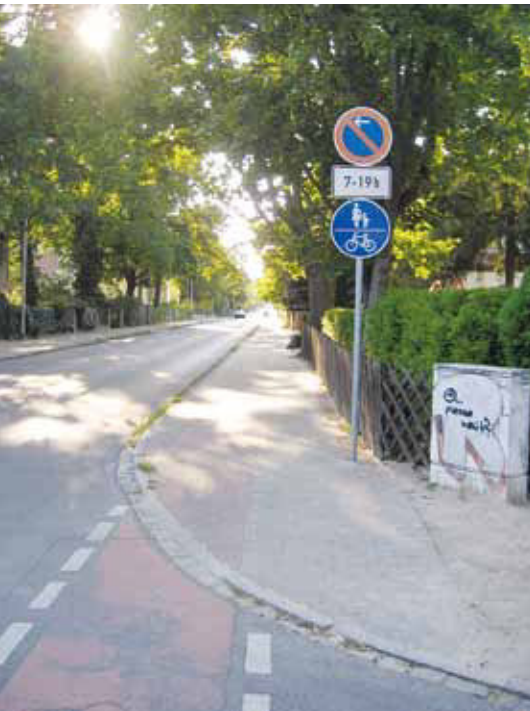
Ernst-Thälmann-Straße: Die schmalen Bürgersteige mit roter Radwegmarkierung dicht an Grundstückseinfahrten bergen die Gefahr der Kollision mit Fußgängern und ausfahrenden Kfz.
